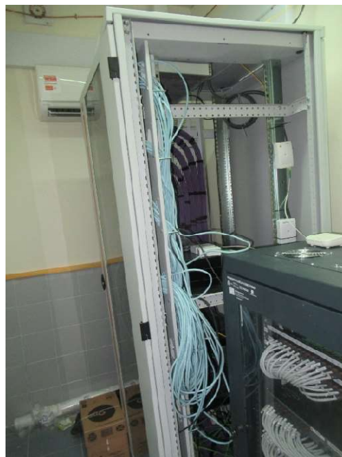
Figura 4: Estado actual de RTIC y Rack A – RT con un armario de bastidor de 42 U.
